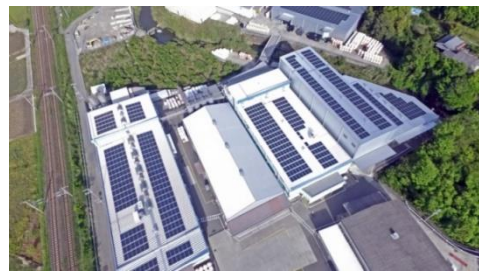
<和歌山工場の太陽光パネル>
